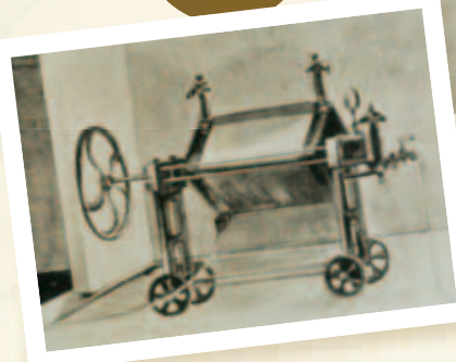
▲ ビールろ過機。綿をろ材として使用し、 ろ過後の綿は洗浄して繰り返し使っていました。
