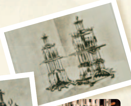
▼ びん詰機。当時のびんは、機械製びんではなく 人口吹きによって製造されたため、びん口の形状が 不揃いで 打栓作業には時間を要しました。
