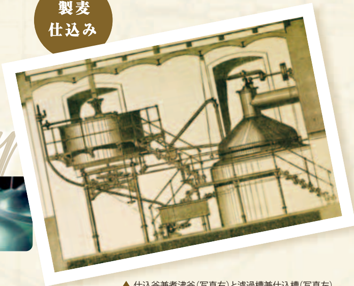
▲ 仕込釜兼煮沸釜(写真右)と濾過槽兼仕込槽(写真左)。 当時は、石炭を燃やした直火で仕込み・煮沸を行っていました。
